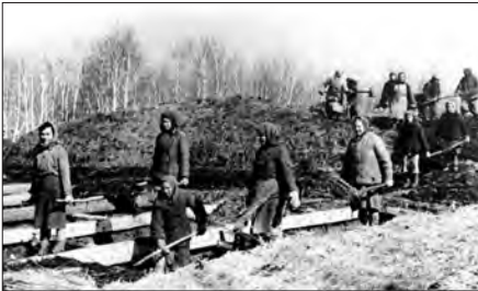
На строительстве парников. 1942 г. Колхоз «Новая жизнь» (Мартюш)
